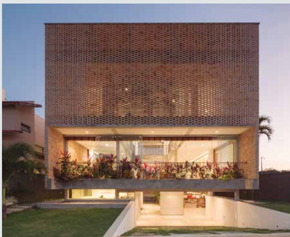
Residência KS. Projeto de Alexandre Brasil Garcia, vencedor da categoria Edificação Residencial do Prêmio Saint-Gobain de Arquitetura. Foto: Joana França
