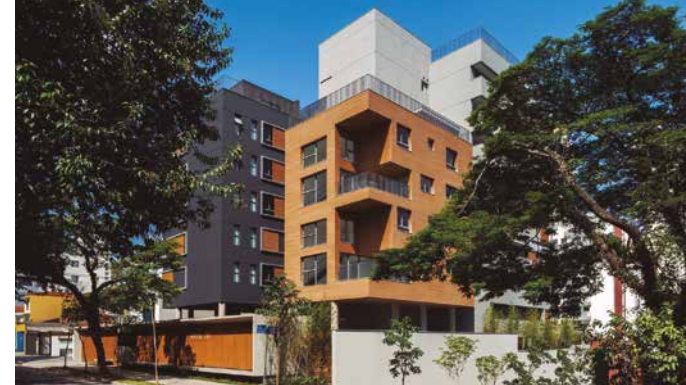
Edifício Aruá, de FGMF Arquitetos. Vencedor do Grande Prêmio da 56ª Premiação Anual do IAB/RJ. Foto: Rafaela Netto
