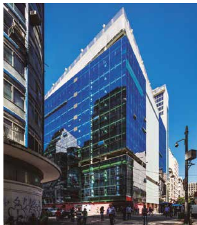
Sesc 24 de Maio, em São Paulo. Projeto de Paulo Mendes da Rocha e MMBB Arquitetos. Obra finalista do Prêmio Mies Crown Hall Américas Prize (MCHAP). Foto: Nelson Kon
