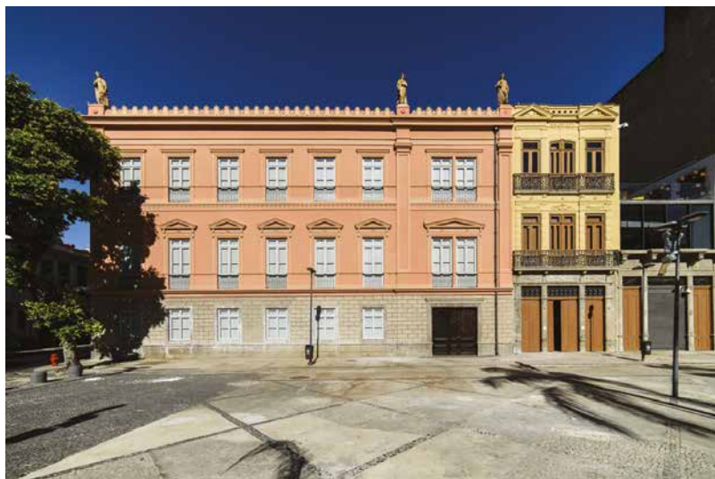
Centro Sebrae de Referência do Artesanato Brasileiro, Rio de Janeiro (RJ). Obra vencedora do Prêmio IAB-RJ, na Categoria Arquitetura de Edificações. Projeto: M&T Mayerhofer & Toledo Arquitetura, Urbanacón e A Rede. Foto: Tiago Tardin
