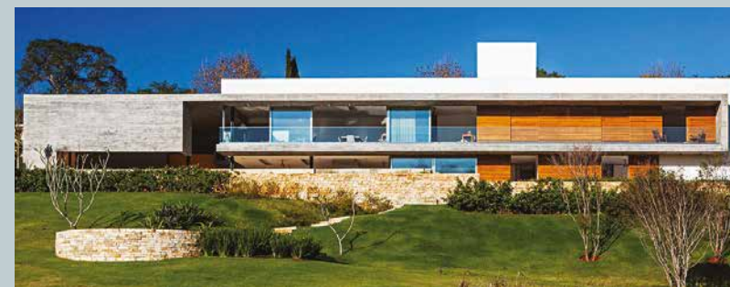
Residência LG, Bragança Paulista (SP). Obra vencedora do Prêmio AsBEA, na Categoria Residência. Projeto: Reinach Mendonça Arquitetos Associados. Foto: Nelson Kon
