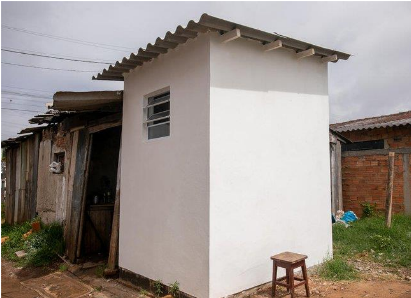
A unidade sanitária contempla tanque externo, fossa séptica e canalização à rede mais próxima da casa. Foto: Guilherme Pereira, Assessoria de Comunicação, Prefeitura de Canoas
