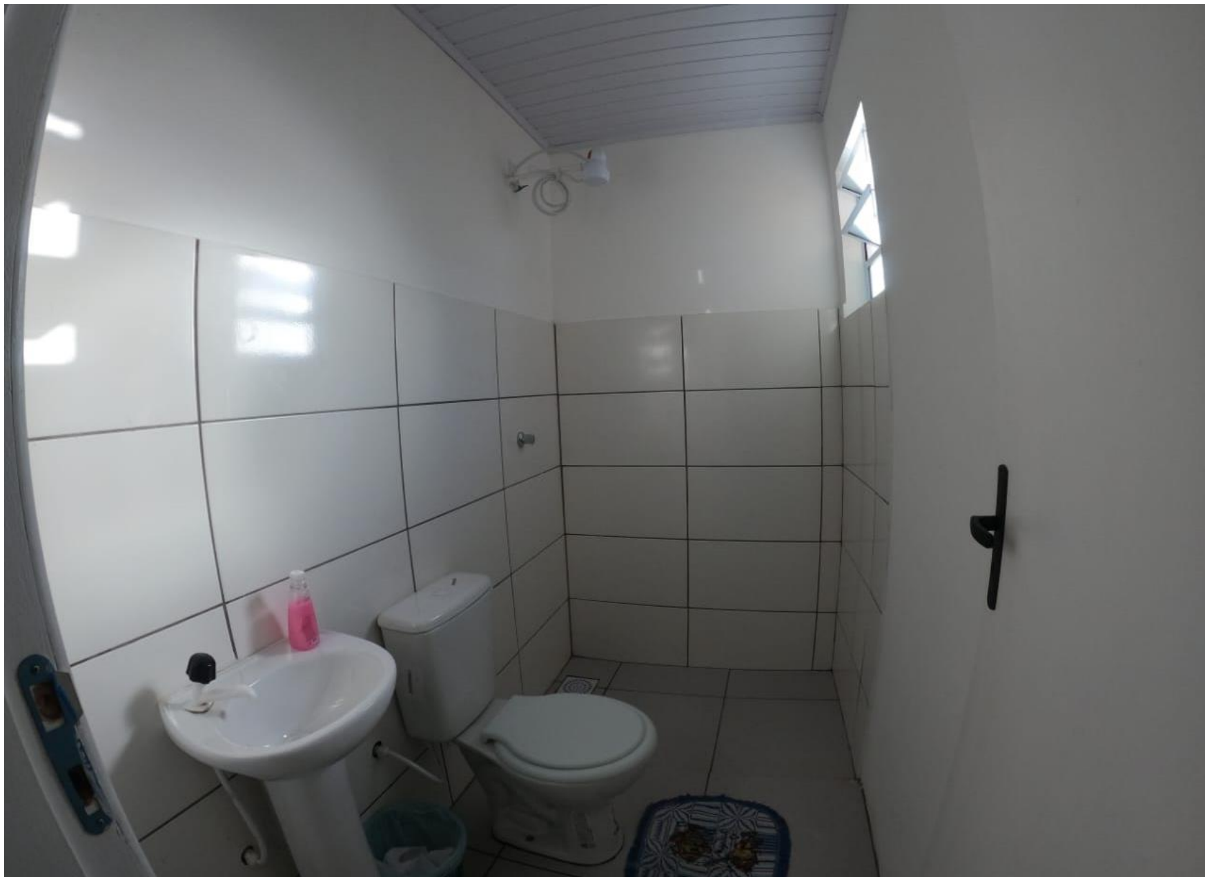
Projeto Nenhuma Casa Sem Banheiro | primeiras unidades sanitárias entregues | Olivia Carlos Henrique Fotos: Luciano Antunes, CAU/RS
