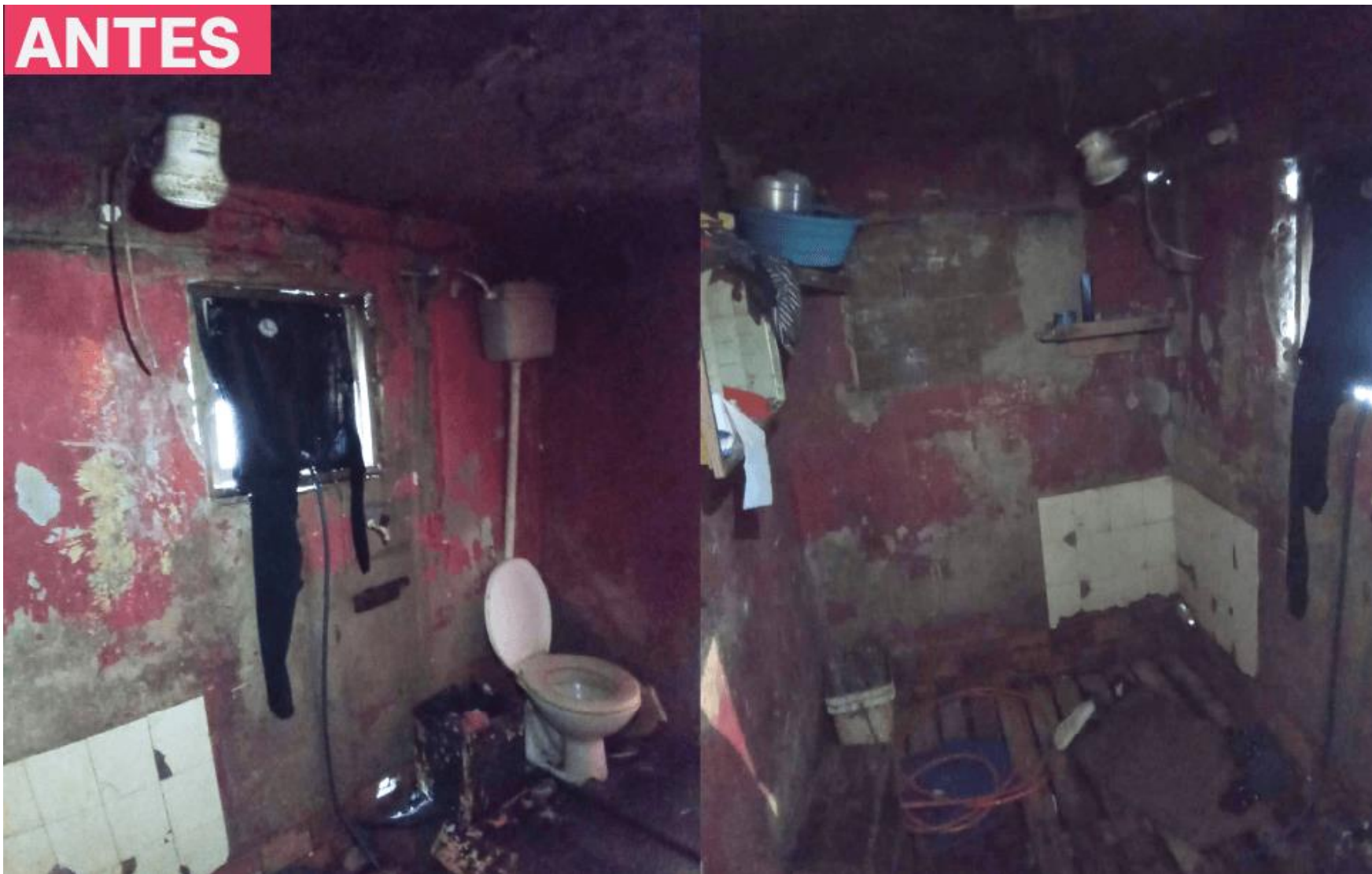
Banheiro existente. Bairro Mariani em Caxias do Sul. Foto: IAB/RS
