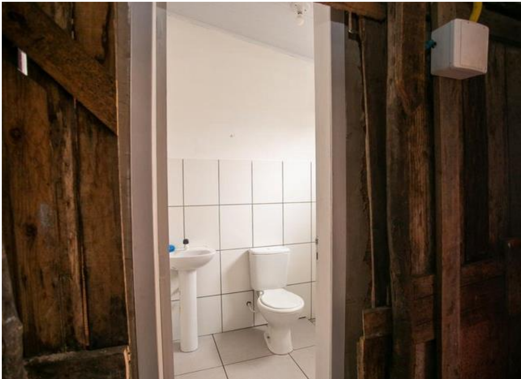
Banheiro construído e adequado à residência da Patrícia através de projeto realizado por arquiteto e urbanista. Foto: Guilherme Pereira, Assessoria de Comunicação, Prefeitura de Canoas
