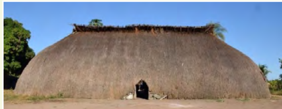
Casa Kamaiurá: "muros que respiran", con capas de paja.
