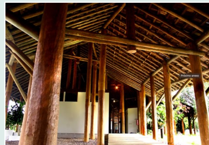
Imagens do Centro de Proteção Ambiental de Balbina (AM), hoje em ruínas
