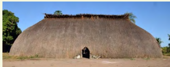
Casa Kamaiurá: “paredes que respiram”, com camadas de palha.
